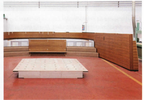
/ Die komplett im CAD geplante Kabine der Yacht wurde zunächst in der Werkstatt aufgebaut.
